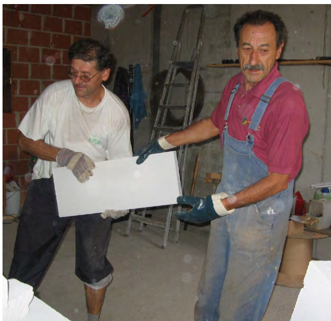
Veliko dela pri gradnji so opravili člani sami, prostovoljno. Glavni »mojster« pri oblaganju kleti s siporeksom je bil Janez Smole (desni), »pomočnik« pa Peter Žula (levi).
